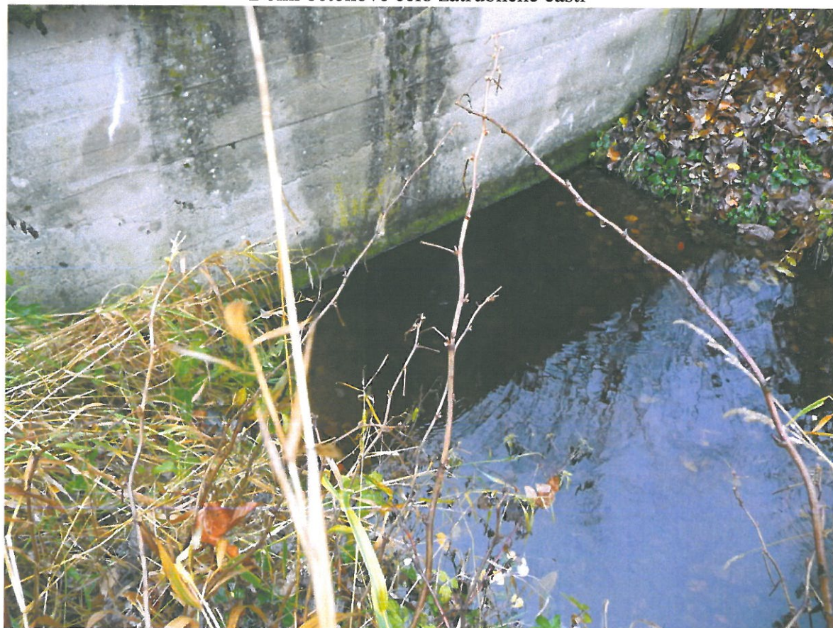
Dolní betonové čelo zatrubněné části
